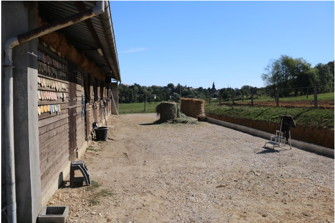
L'emprise du terrassement des futurs boxes
