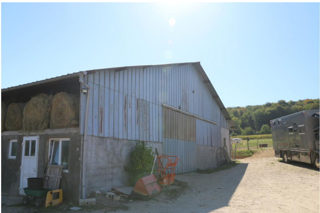
Le bâtiment agricole existant
