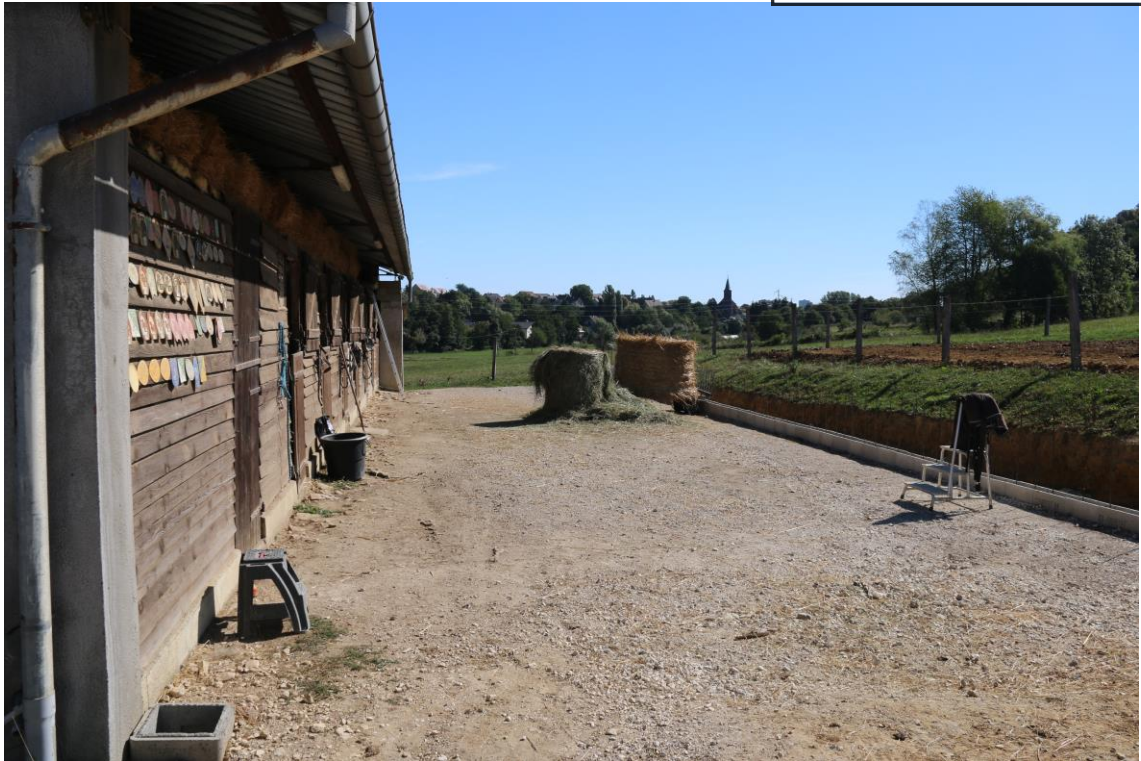
L'emprise du terrassement des futurs boxes
