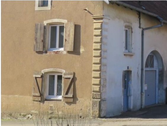
Exemples locaux de modénatures* (chainage d'angle, encadrement des fenêtres) conservés apparents.
